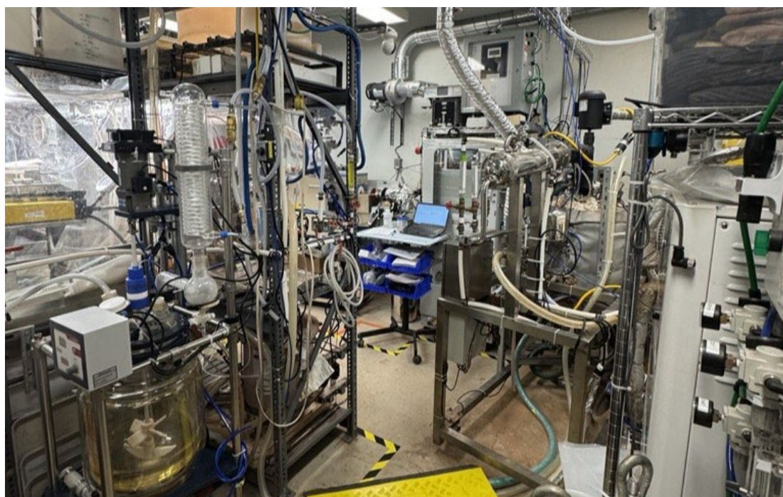
Figure 4: Usine pilote dans les installations de Boucherville
